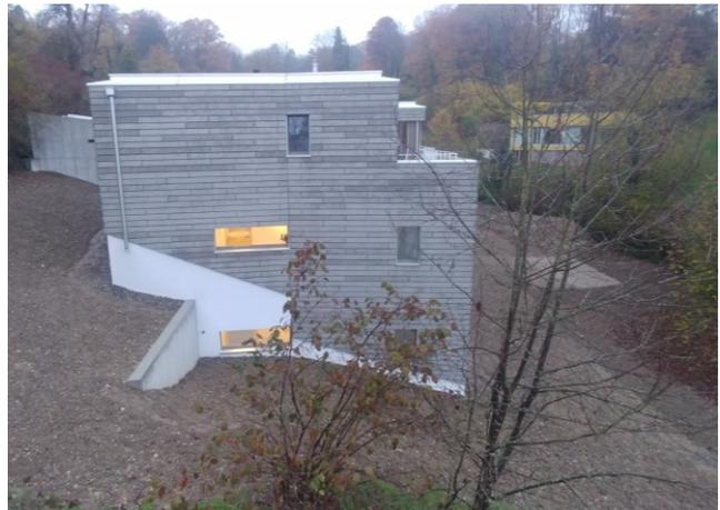
Abbildung 3 (links): Kehr-, Vorplatz und Carport. Das Regenwasser versickert durch die Chaussierung (rechts): Seitenansicht der Gebäude, kurz nach Fertigstellung. Gut sichtbar sind die verschiedenen gemischten Erdbereiche, die das Regenwasser je nach Kiesanteil zurückhalten. Rechts ist der Mockentobelbach (Vorfluter).
