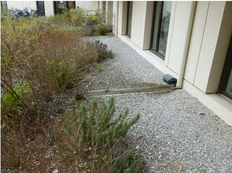
*Abbildung 3: oberflächliche Ableitung des Dachwassers*
