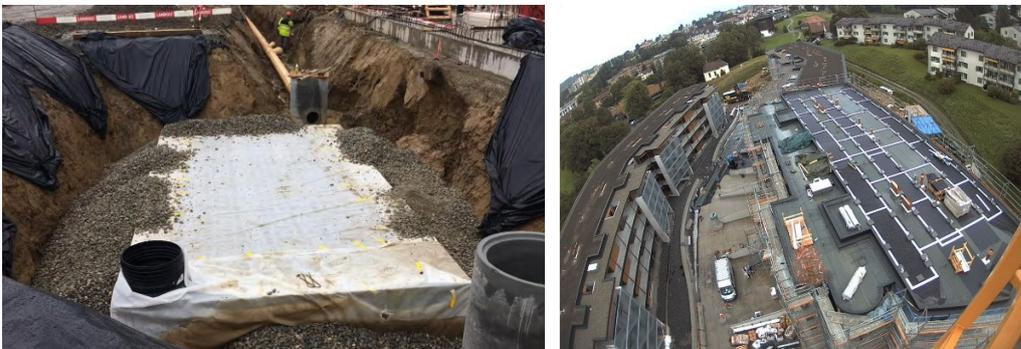
Abbildungen 2 und 3: (links) Kombinierte Retentions- und Versickerungsanlage aus Geogitterkörpern, (rechts) Übersicht Arealüberbauung während der Ausführung
