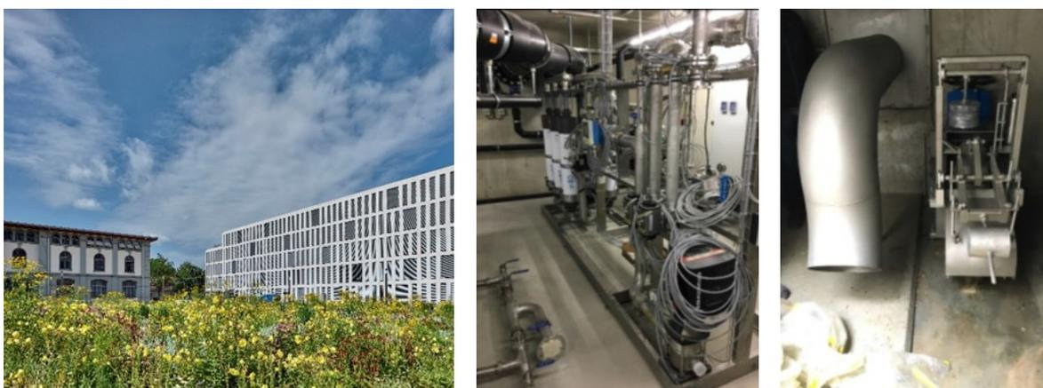
Abbildung 2 (links): Versickerungsanlage, (Mitte): Aufbereitung Regenwasser zu Brauchwasser, (rechts): Abflussdrossel, Retention mit Notüberlauf
